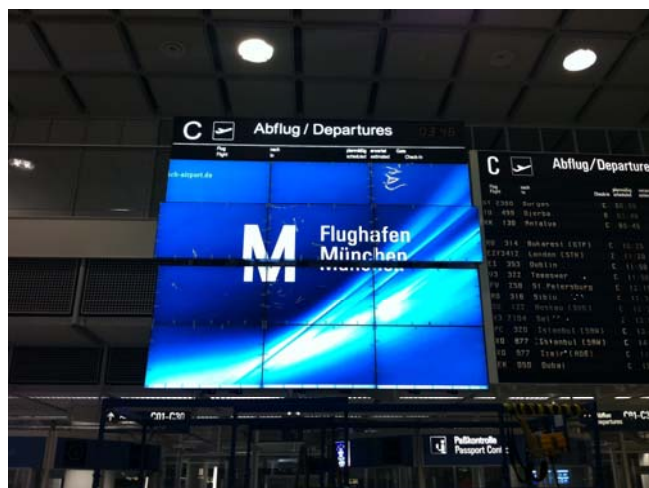
Installationsbeispiel: Flughafen München
