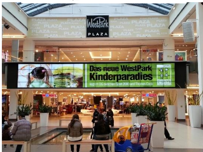
Installationsbeispiel Westpark Ingolstadt
